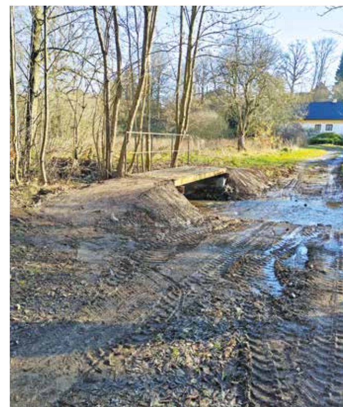
Oprava lávky ve Vozovici
