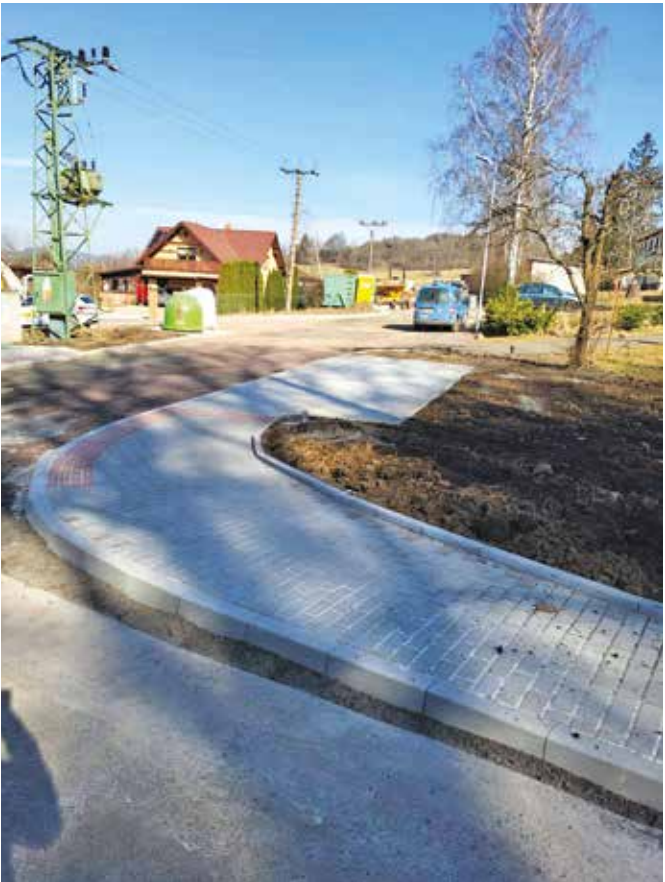
Probíhající výstavba točny pod bytovkami
