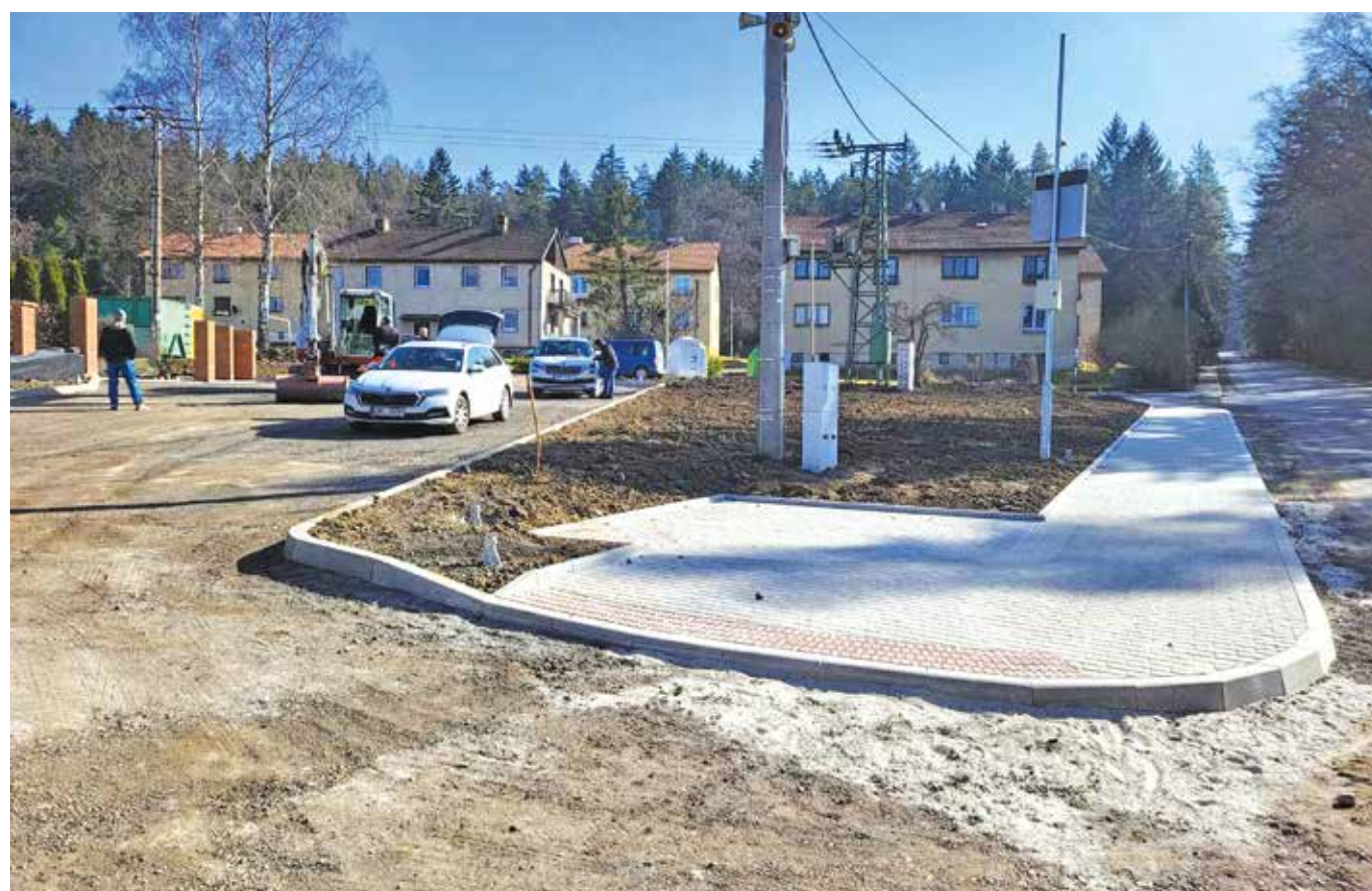
Probíhající výstavba točny pod bytovkami
