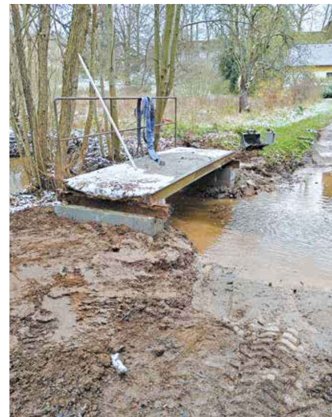
Oprava lávky ve Vozovici
