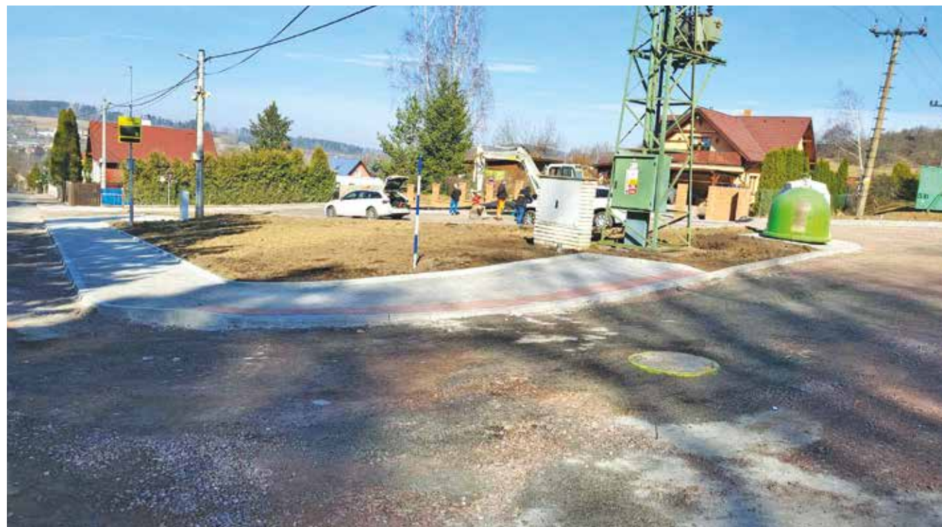
Probíhající výstavba točny pod bytovkami
